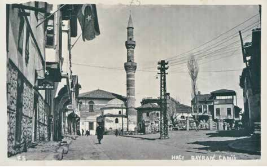
Hacı Bayram Cami'nin Hükümet Caddesi üzerinden görünüşü 1932. Fotoğrafta önde Hacı Bayram Türbesi, İsmail Fazıl Paşa Türbesi ve Arkeoloji Müzesi açık hava sergi alanı görülüyor. Sol tarafta bulunan bayrak asılı bina üzerinde, 'Zabıta Belediye Merkez Memurluğu' yazılı bir tabela yer alıyor (Fotoğraf: Cumhuriyet'in Başkenti, Atilla Cangır, Cilt II, s.795, 2007, Ankara Üniversitesi Yayını).
