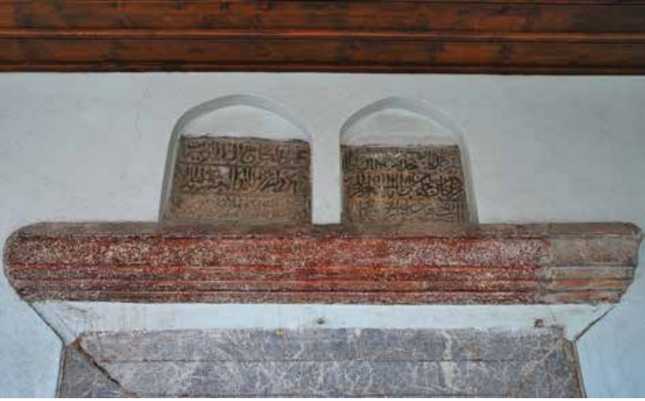
Alaaddin Cami'nin harim kapısı üzerinde bulunan onarım kitabeleri 2014 (Fotoğraf: Yavuz İşçen).
